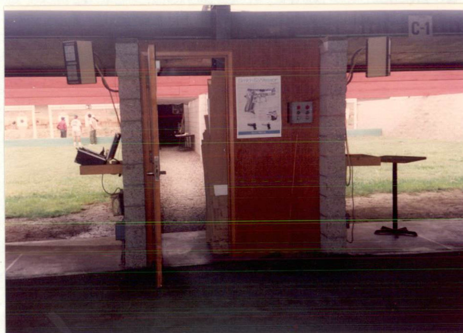
Vista del pasaje de seguridad en la galería de 25 mts. para el personal de jueces que califican el valor de los impactos en los blancos.
