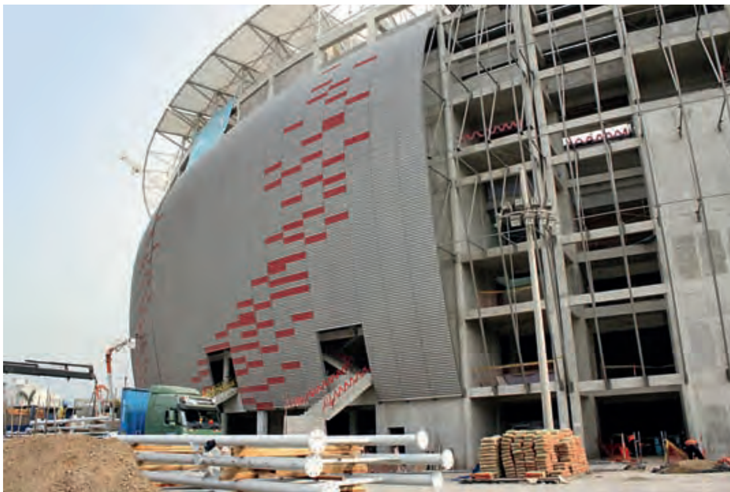
■ Obra: Rehabilitación, remodelación y equipamiento de la infraestructura deportiva del Estadio Nacional – colocación de cubierta de fibra de vidrio.
