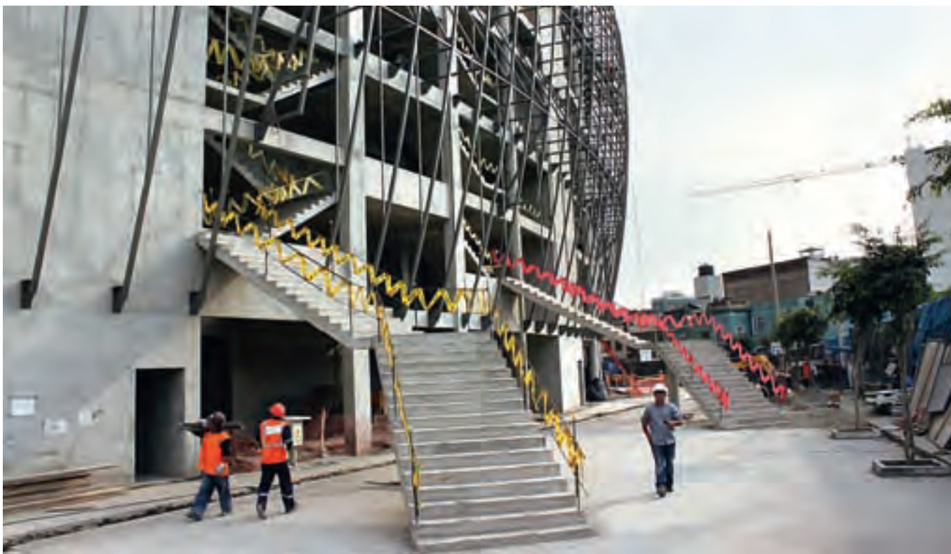
■ Obra: Rehabilitación, remodelación y equipamiento de la infraestructura deportiva del Estadio Nacional – construcción de acceso para palcos.
