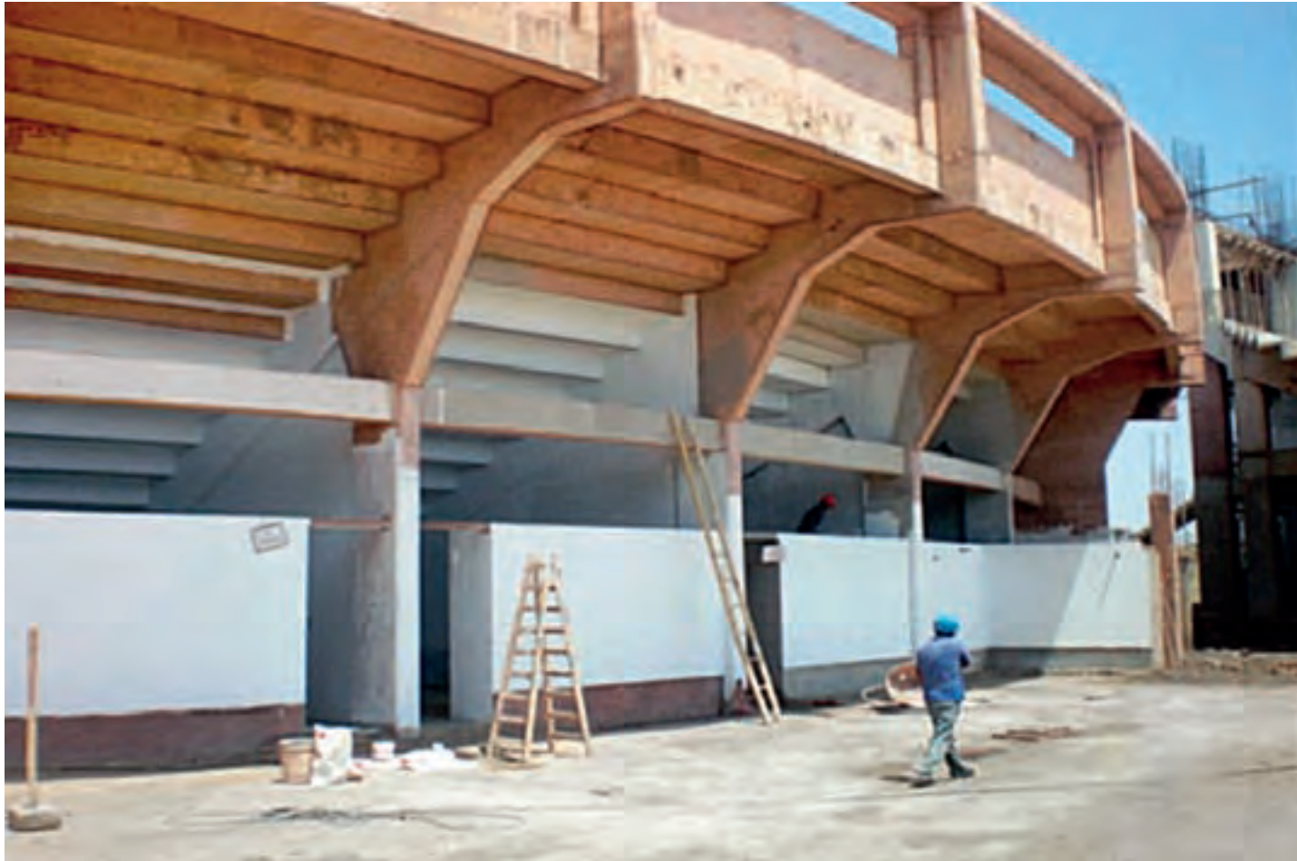
■ Construcción del Coliseo Cerrado de Sullana - Piura.
