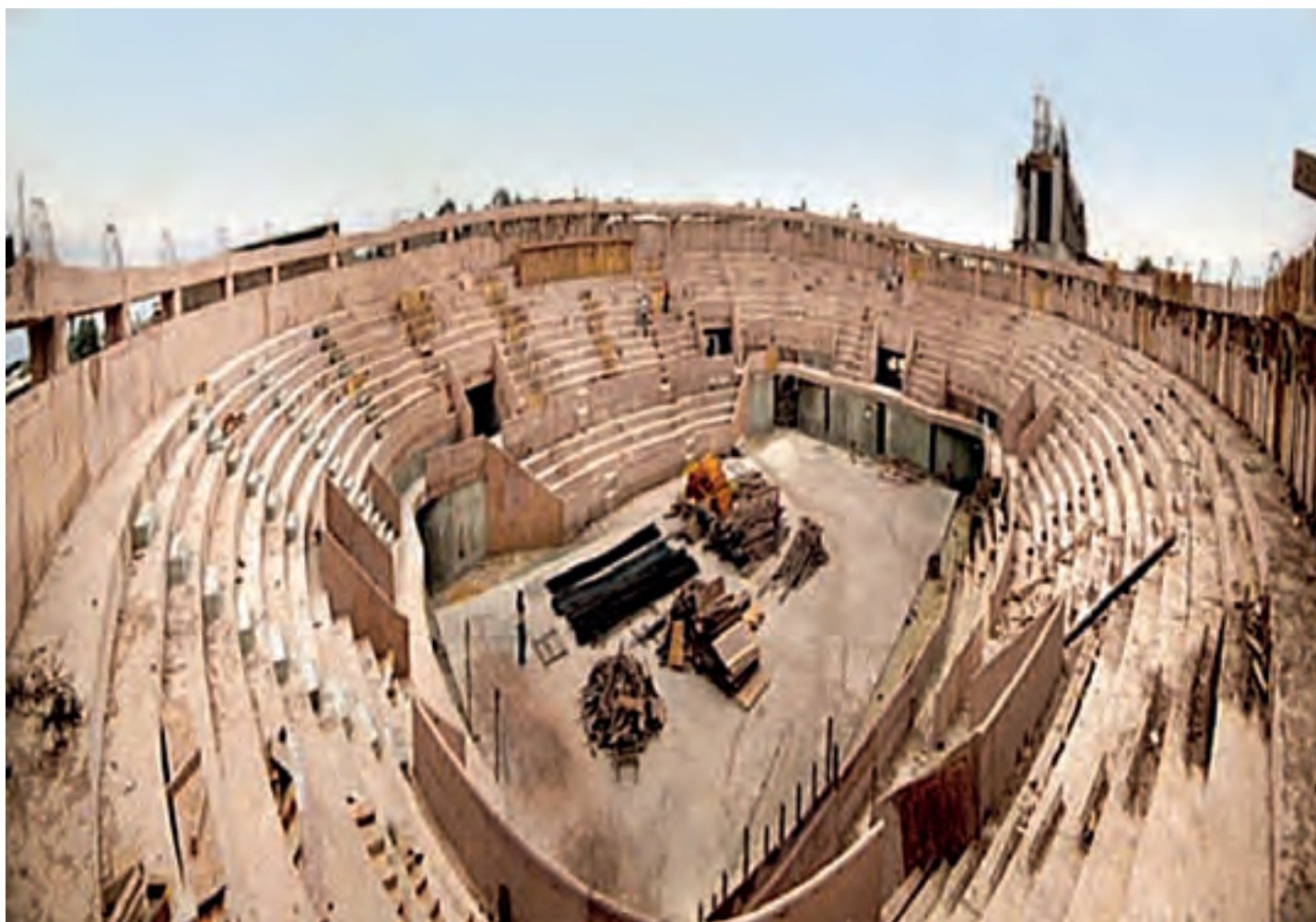
■ Construcción del Coliseo Cerrado de Sullana – Piura.
